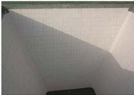
Plain Tile Lining the Hopper Plain tile Revestimiento la tolva
